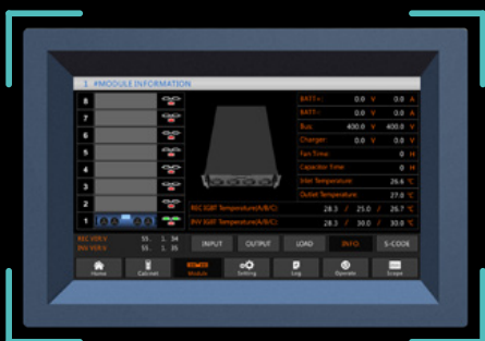
Schermata informazioni sullo stato dei moduli di potenza.
